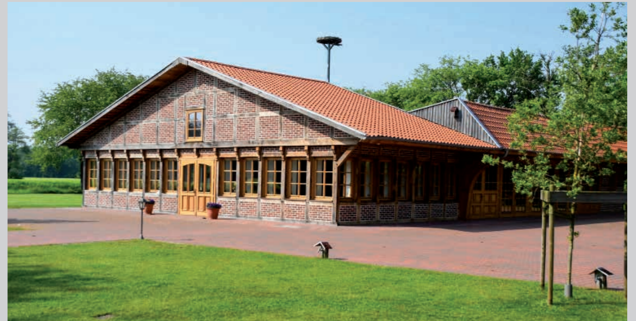
Lemkes neue Trauerhalle ist im Artländer Fachwerkstil eingerichtet
